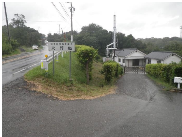
写真一 1 0 県道 52 号線からの進入道路（鋭角に取り付けられている）
