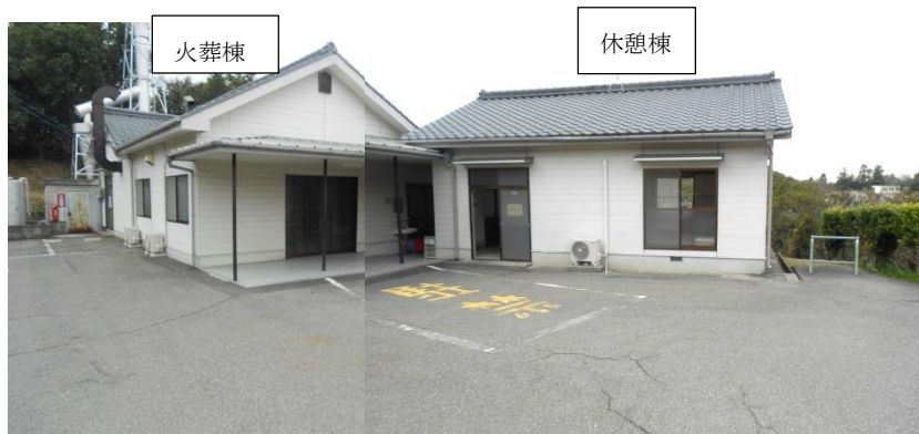
写真一 2 施設全景
