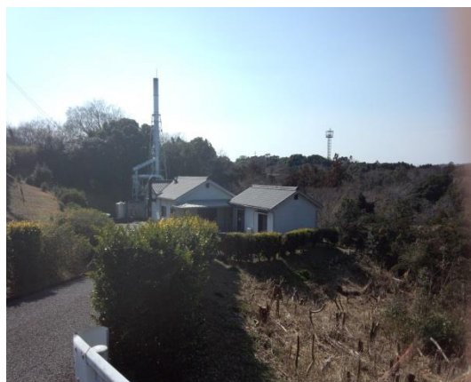
写真一 1 2 進入路北面（急傾斜地）
