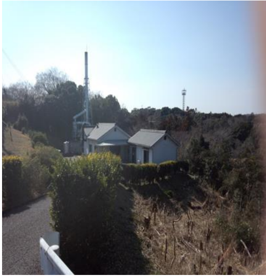
写真 7-3 進入路北側の傾斜地
